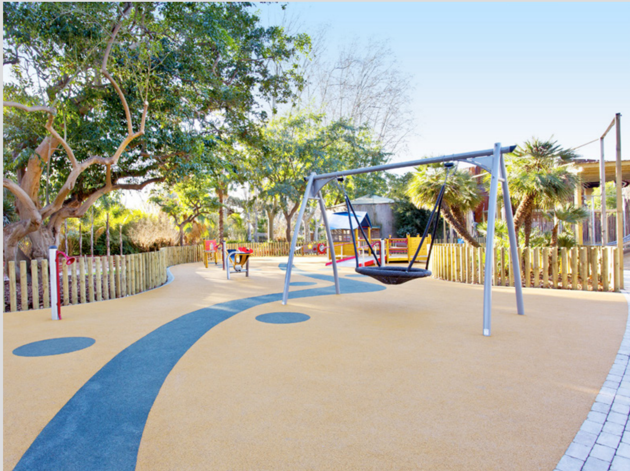
— Construcció de zona de jocs adaptats al Zoo de Barcelona. FOTO: Sònia Tapiolas.
