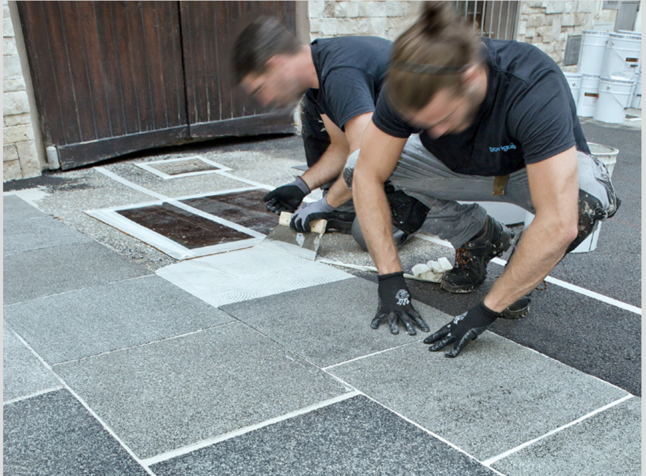
Aplicació de sistema Firflex a Tiana, Barcelona. FOTO: Sònia Tapiolas.
