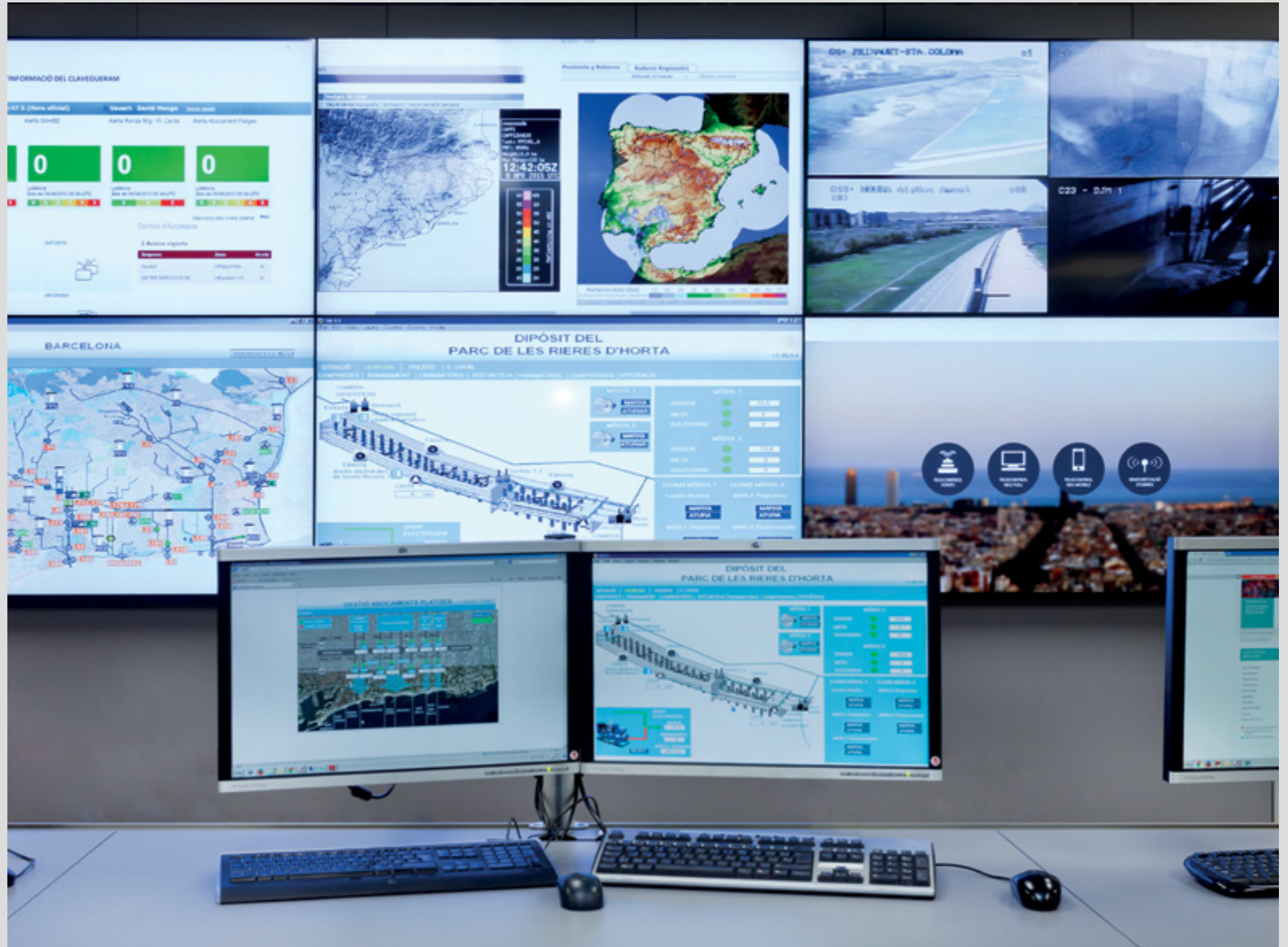
Centro de control 24 x 7 para Barcelona Cicle de l'Aigua, SA (BCASA). Ayuntamiento de Barcelona. FOTO: Sònia Tapiolas.
