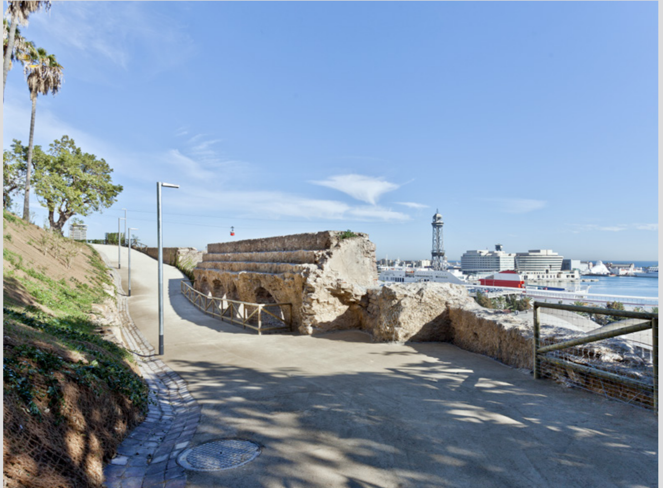
Improving the structural safety of Montjuïc Forestier stairs, Barcelona. PHOTO: Sònia Tapiolas.
