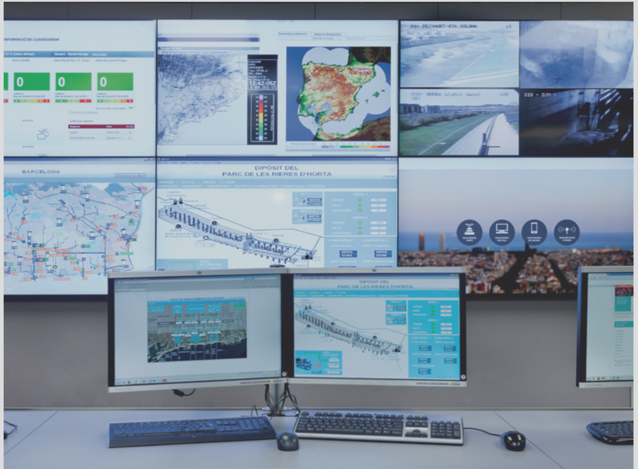
Center of control 24 x 7 for Barcelona Cicle de l'Aigua, SA (BCASA). Ayuntamiento de Barcelona. FOTO: Sònia Tapiolas.
