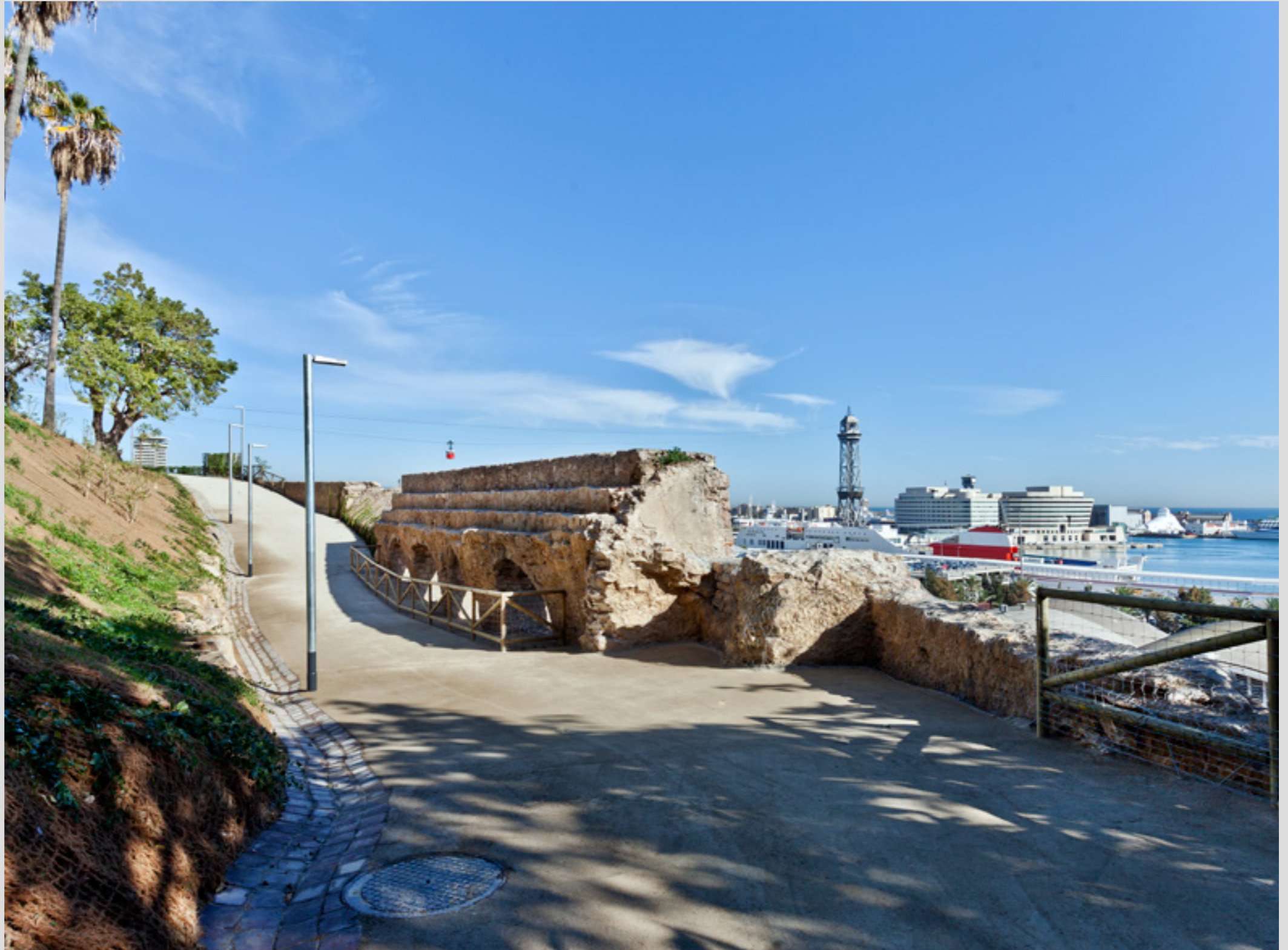
Mejora de la seguridad estructural de las Escaleras Forestier en Montjuic, Barcelona. FOTO: Sònia Tapiolas.
