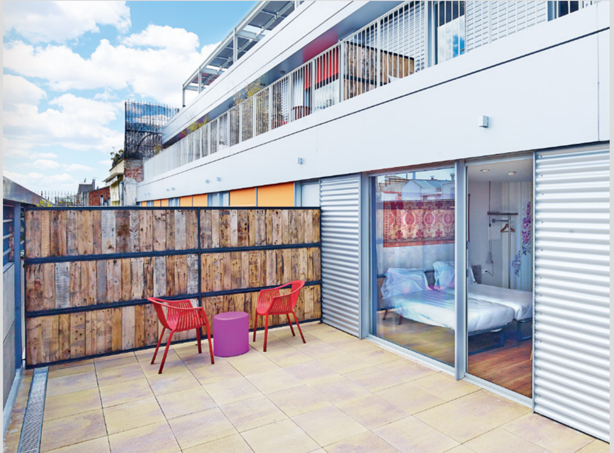
Rehabilitación de edificio para uso hotelero: Hostal Generator, Barcelona. FOTO: Jordi Bernadó.
