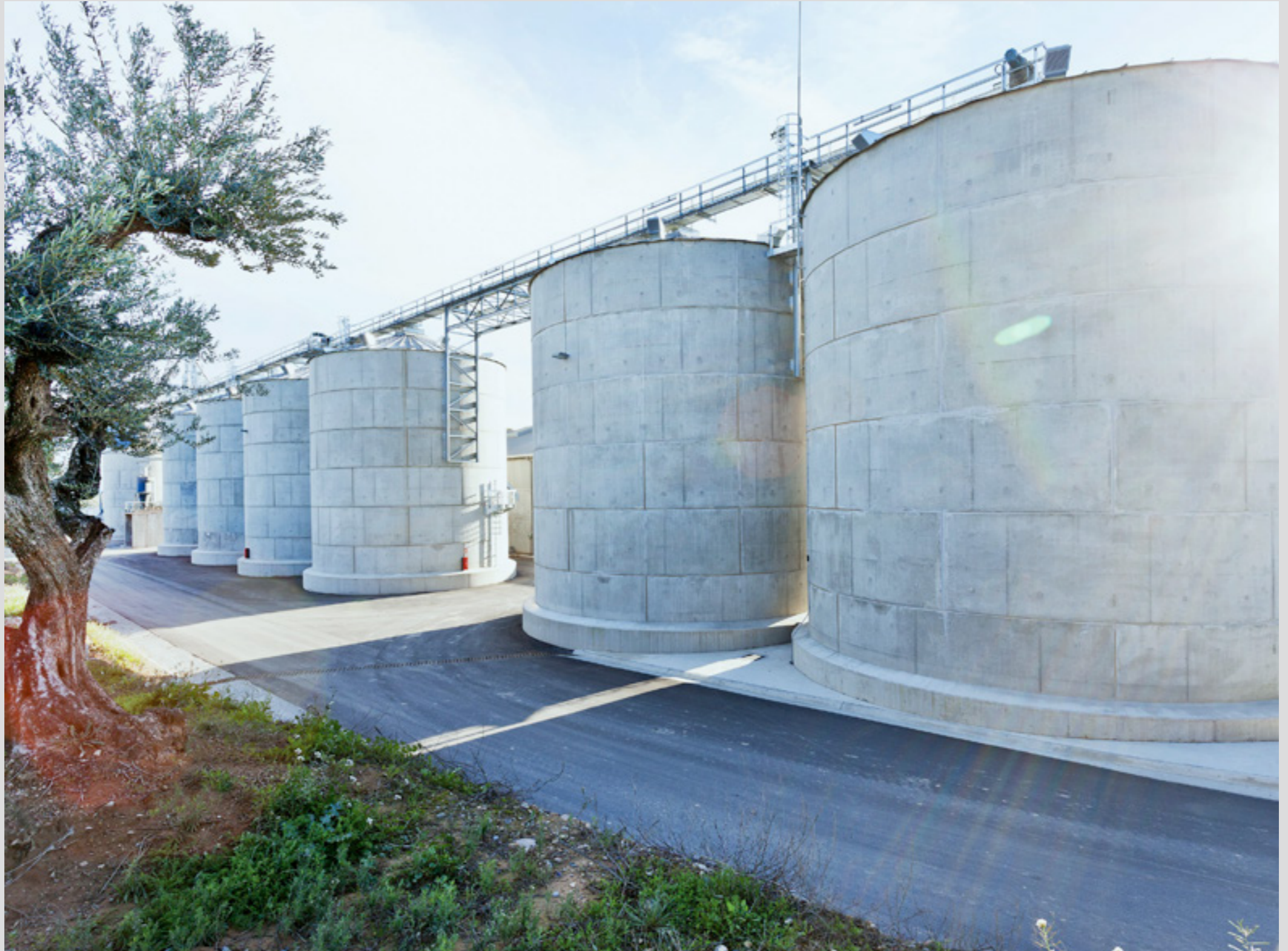
— Construcción de una nave de cereales en La Plana del Corb (Balaguer, Lleida). FOTO: Sònia Tapiolas.
